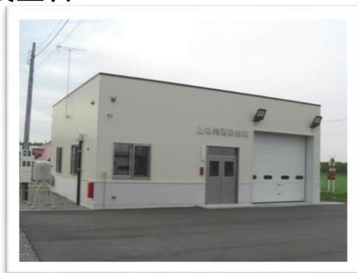
上札内消防会館
