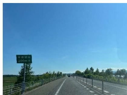
帯広・広尾自動車道
