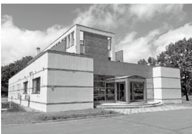
定期的改修を必要とする村の浄化センター。 平成9年開設
