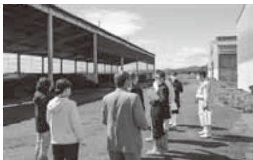
堆肥化処理施設
