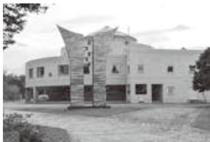
今後改修が予定される小学校の校舎
