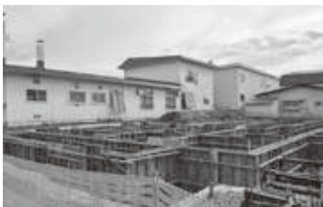
ひばり荘建替え工事現場
