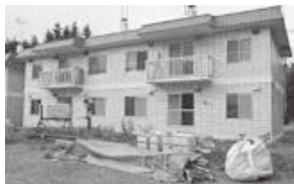
改修工事が着手される中札内団地
