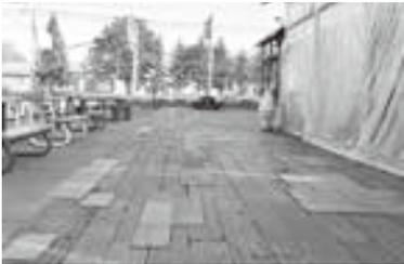
腐食した部分を板で補修している
