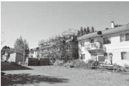
改修工事が着手される中札内団地
