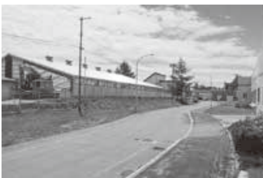
改修中の屋内多目的運動施設の西側道路
