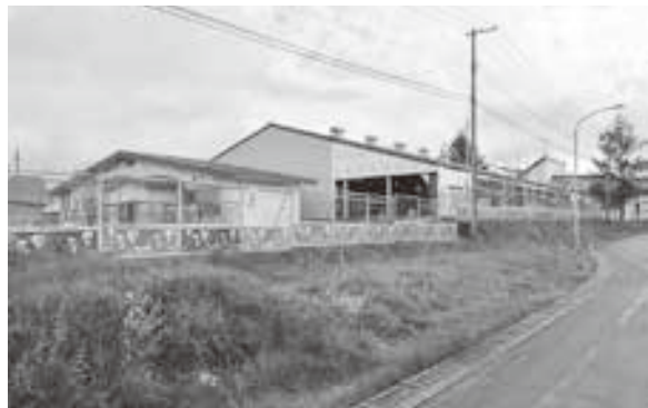
12月からの供用開始に向けて工事が進んでいる
