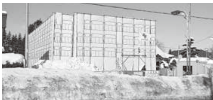
街中のにぎわいづくりと定住促進を目的に建設が進められている公営住宅(北1区)
