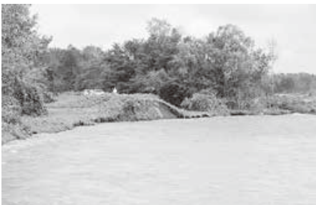
台風10号の大雨により増水し決壊した札内川堤防(西札内地区)
