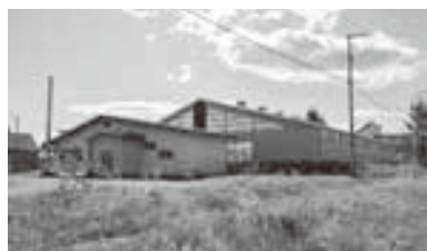
改修される旧中札内プール
