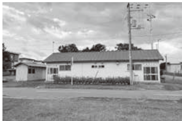
補助金により興農区会館が新築される
