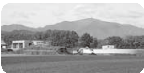
バイオガスパラント建設工事の様子
