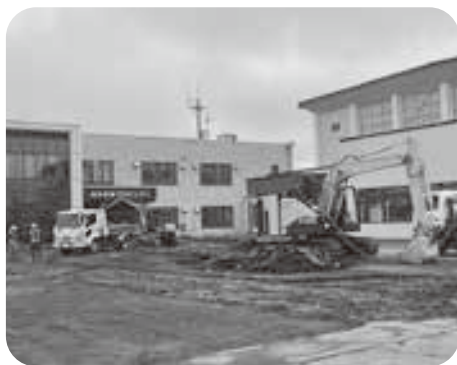
まちなかキッチンスタジオ外構工事 舗装を撤去し、路盤から再整備する
