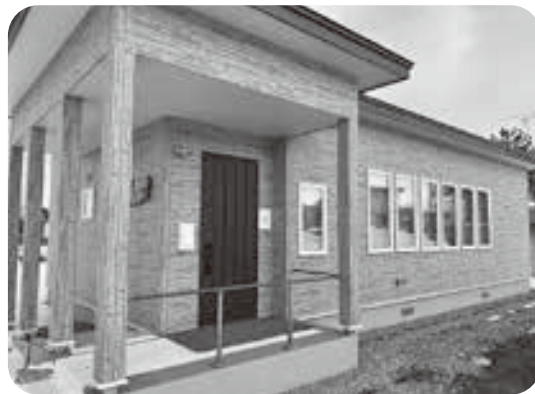
助成事業により建設された興農会館
