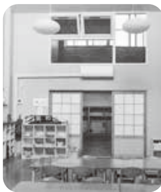
教室、遊戯室、職員室等にエアコンが設置された
