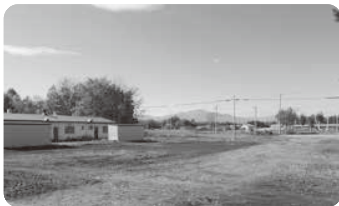
令和6年から7年度にかけ泉団地の解体撤去が行われる
