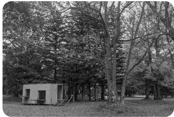
平成28年にバンガローが大雨で流されたためトレーラーハウスを整備した
