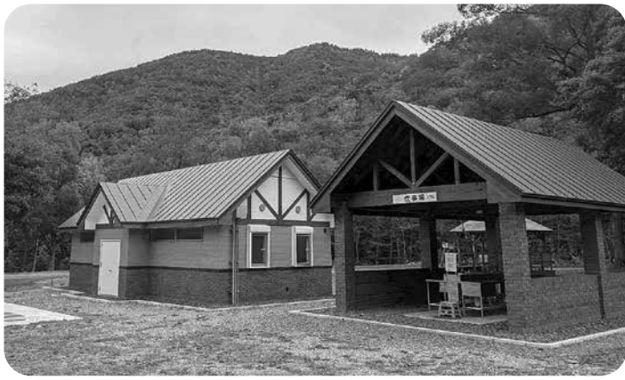
6年度整備されたトイレと炊事場
