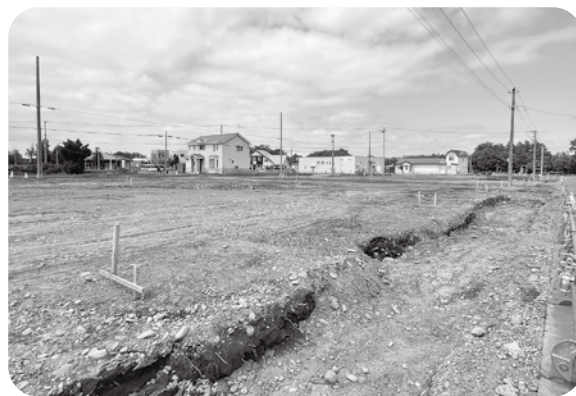
20区画の宅地分譲造成工事が着工された
