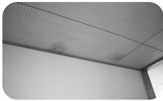
改修により雨漏りや室内環境を改善予定
