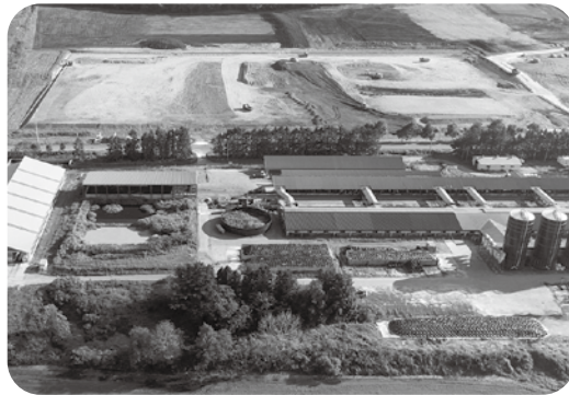
完成が待たれる大規模草地整備工事
